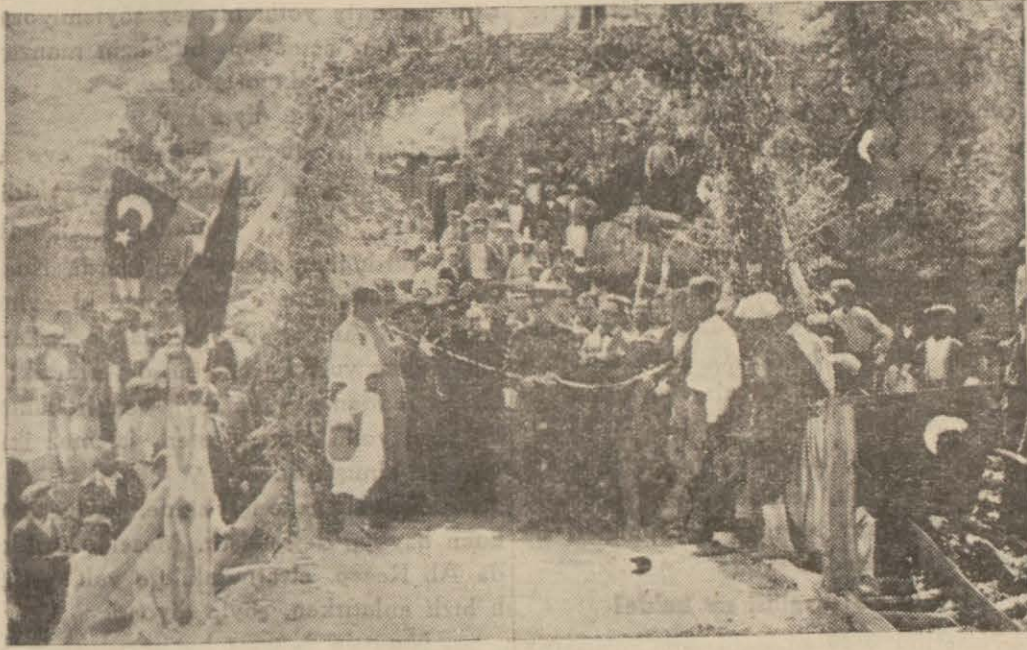
Pertek köprüsü gelip geçişe açılırken
